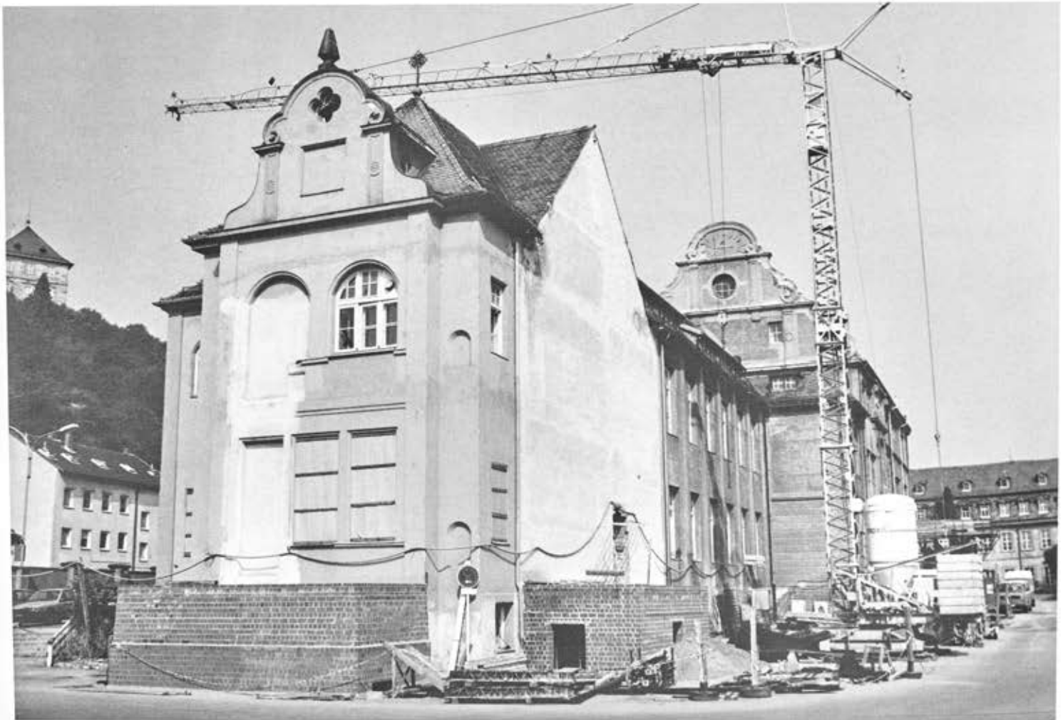
Bauarbeiten zur Ergänzung des Ost- und Südostteils, 1989
