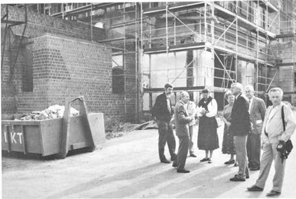
„Pressekonferenz“ an der Baustelle, 1989
